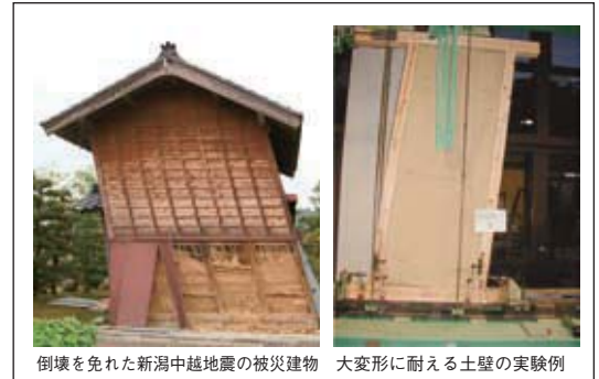
写真1 伝統的な木造建築と土壁のねばり強さ
